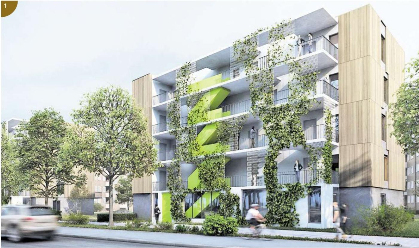
1. Das hannoversche Büro BTP Architekten setzt auf vorgefertigte Fassadenteile aus Holz. Das soll die Kosten reduzieren.
